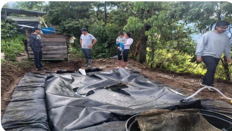
Instalación de biodigestores para pequeños productores agropecuarios
